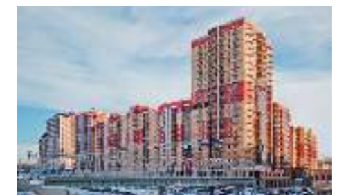
ЖК «Солнечный город», Казань «АК БАРС Строй»
